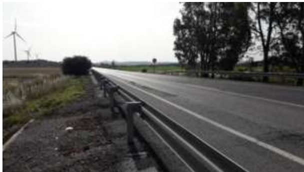
Vista hacia la izquierda desde punto previsto para nuevo acceso
